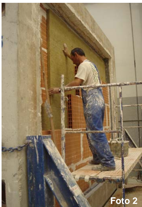
Fotos 2 y 3: Montaje de segunda fábrica de LGF de 7 sobre banda perimetral de poliestireno expandido elastificado
