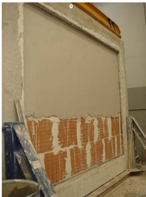
Foto 4: Aplicación de revestimiento de yeso
