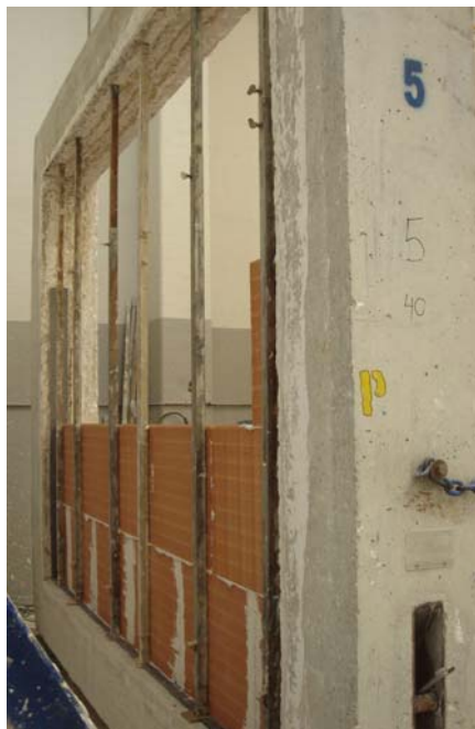
Foto 1: Montaje de primera fábrica de LGF de 7 sobre banda perimetral de poliestireno expandido elastificado
