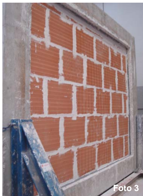
Fotos 2 y 3: Montaje de segunda fábrica de LGF de 7 sobre banda perimetral de poliestireno expandido elastificado
