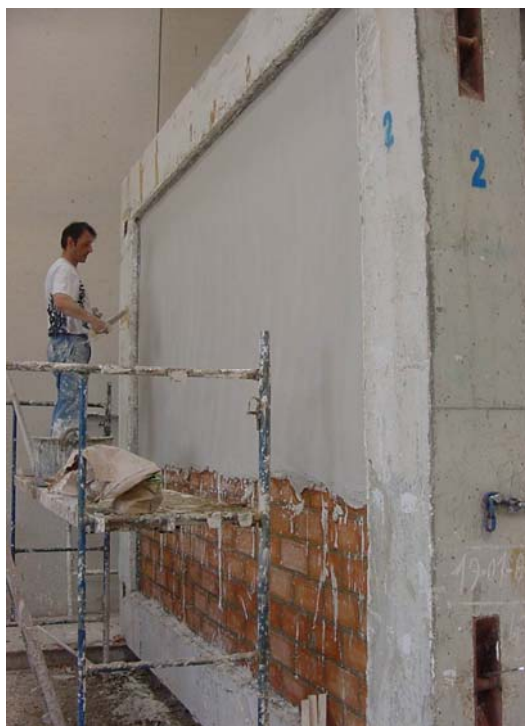
Foto 3: Guarnecido y enlucido de yeso de la fábrica de LHD de 9 sobre banda perimetral de poliestireno expandido elasticado
