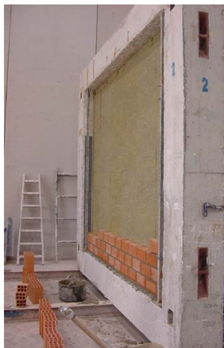
Foto 2: Construcción de la segunda fábrica de LHD de 9 sobre banda perimetral de poliestireno expandido elastificado
