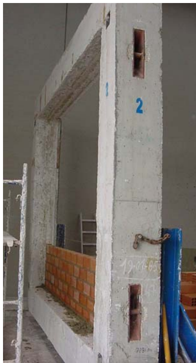
Foto 1: Construcción de la primera fábrica de LHD de 9 cm
