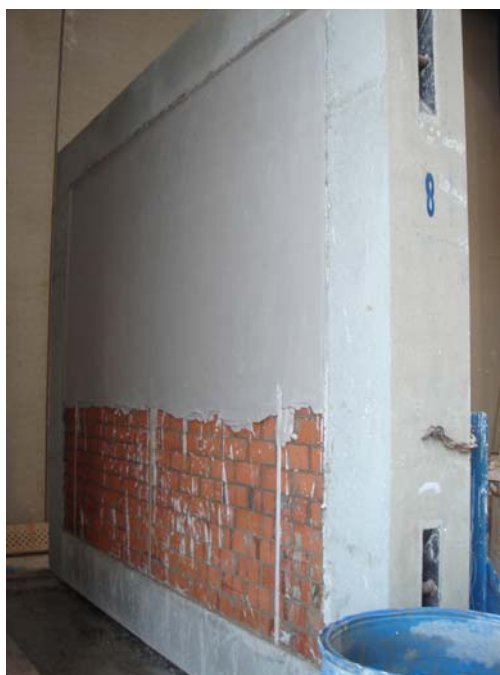
Foto 3: Aplicación de revestimiento de yeso
