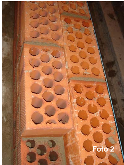
Fotos 1-2: Construcción del cerramiento de doble ladrillo perforado
