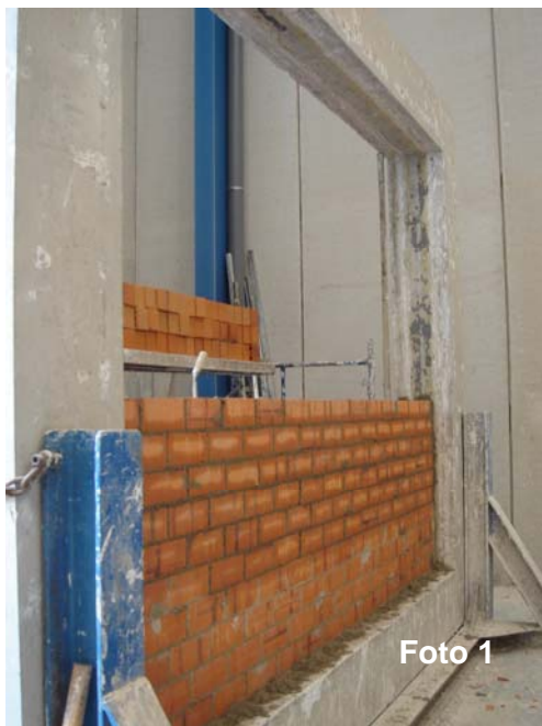
Fotos 1-2: Construcción del cerramiento de doble ladrillo perforado
