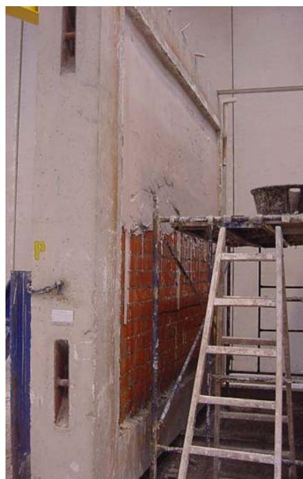
Foto 3: Enlucido de la fábrica
