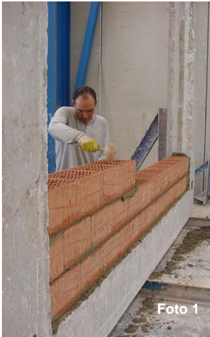
Fotos 1 y 2: Construcción de fábrica de bloque “Termoarcilla de 24”
