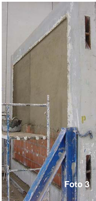
Fotos 3 y 4: Aplicación del enfoscado de mortero (foto 3) y del enlucido de yeso (foto 4)
