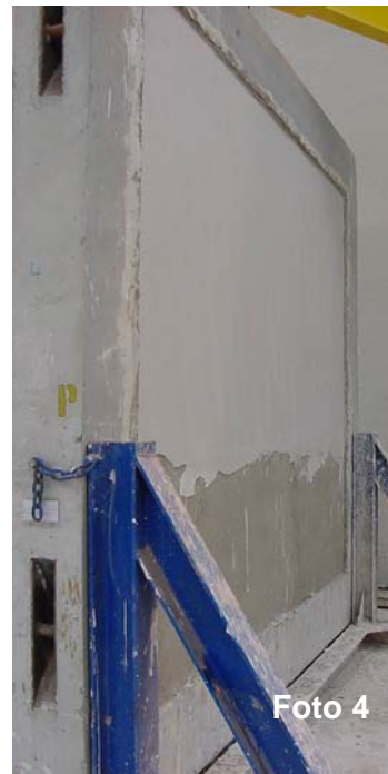
Fotos 3 y 4: Aplicación del enfoscado de mortero (foto 3) y del enlucido de yeso (foto 4)
